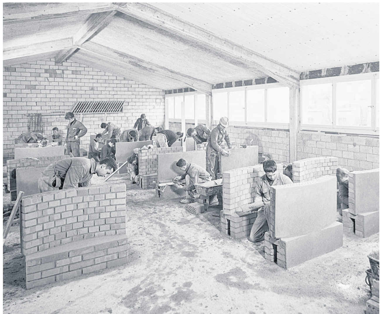
Schweizer Baumeisterverband, Lehrlinge bei der Arbeit in der Maurerlehrhalle, 27. April 1964
